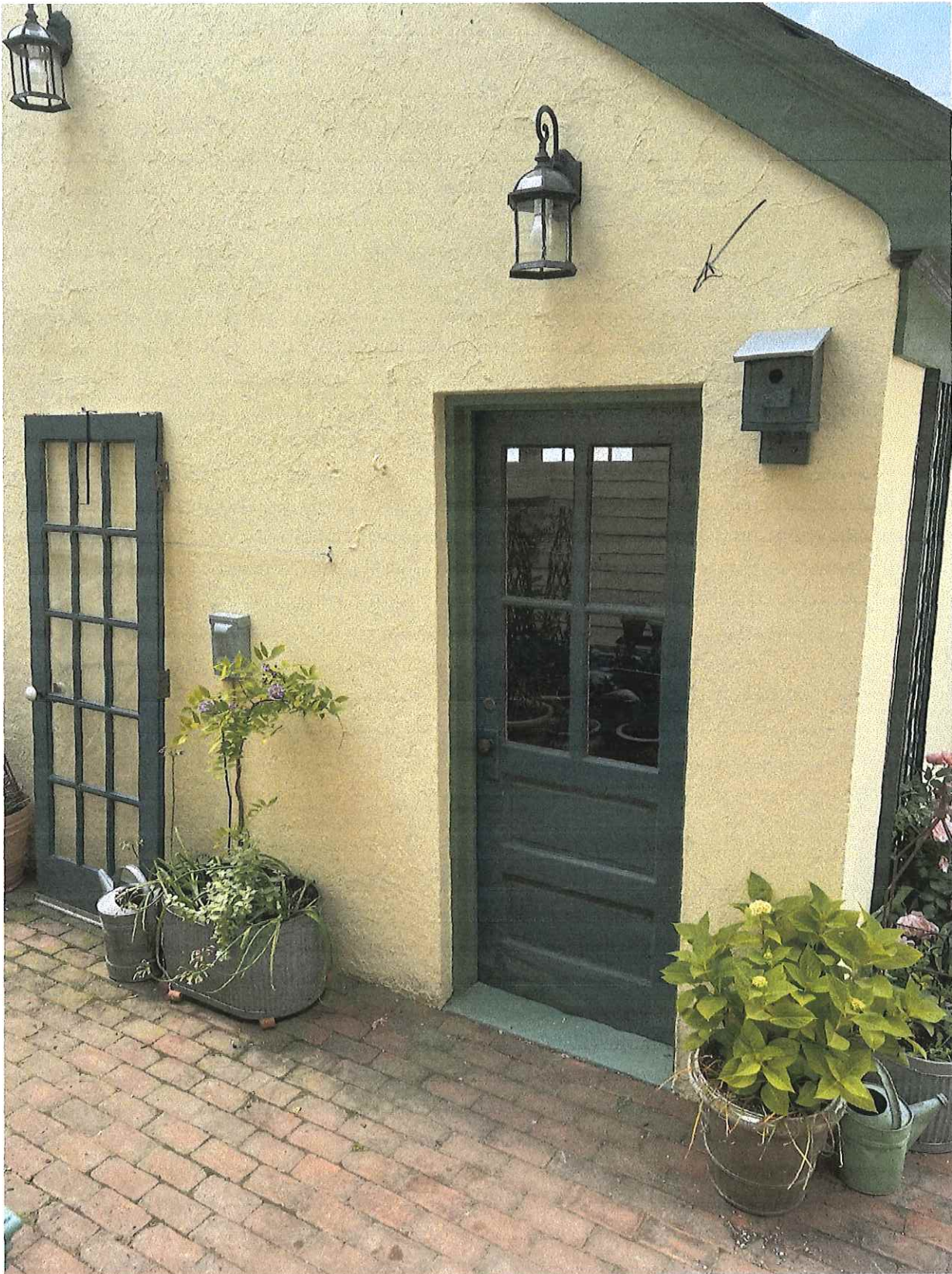
Existing garage door
